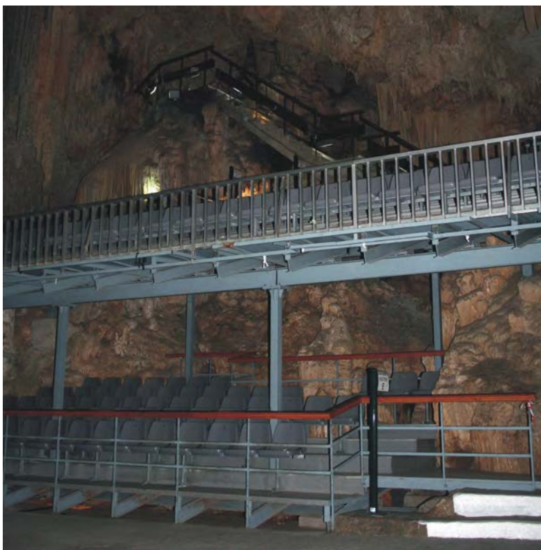
Figura 1. Vista parcial del graderío instalado en la Sala de la Cascada.
