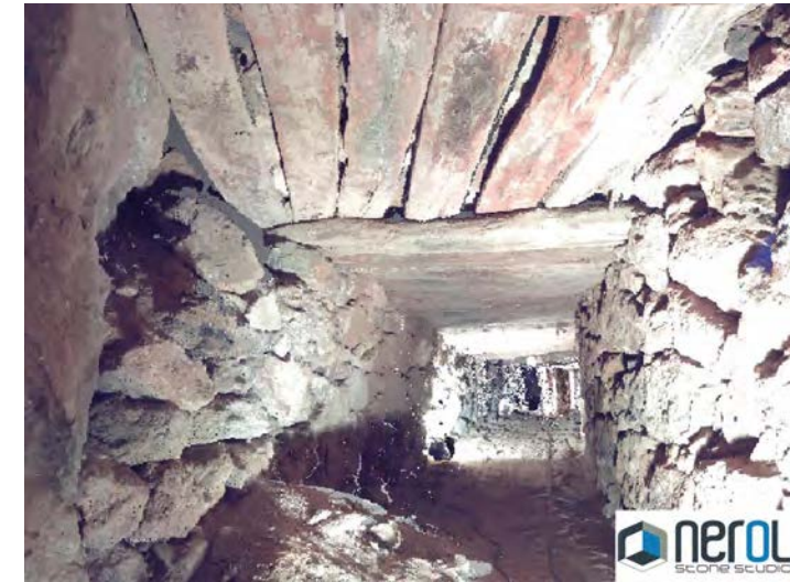
Figura 5. Nube de puntos resultado del escaneo – Galerías de acceso a la Geoda.
