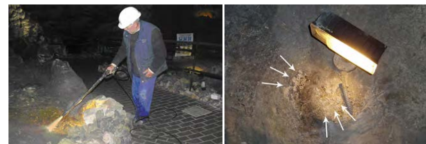
Figura 5. Manchas blancas tras el tratamiento con agua oxigenada – Limpieza con agua a presión.
