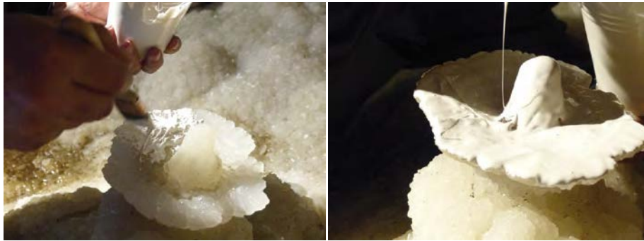
Figura 5. Aplicación de silicona tixotrópica de forma puntual y fluida mediante colada.
