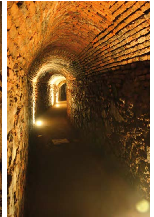
Figura 3. Galerías revestidas de mampostería del siglo XVII.
