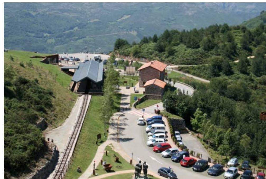
Figura 2. Vista parcial de las instalaciones de El Soplao.
