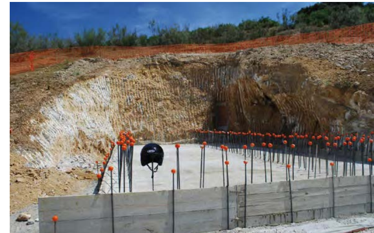
Figura 14. Inicio de la construcción de la sala de recepción y puerta de entrada (esquina derecha).
