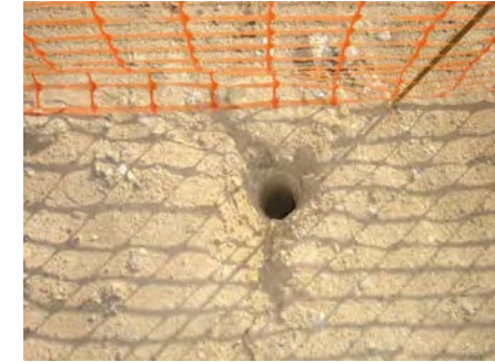
Figura 13. Sondeos realizados para la localización de la cavidad.
