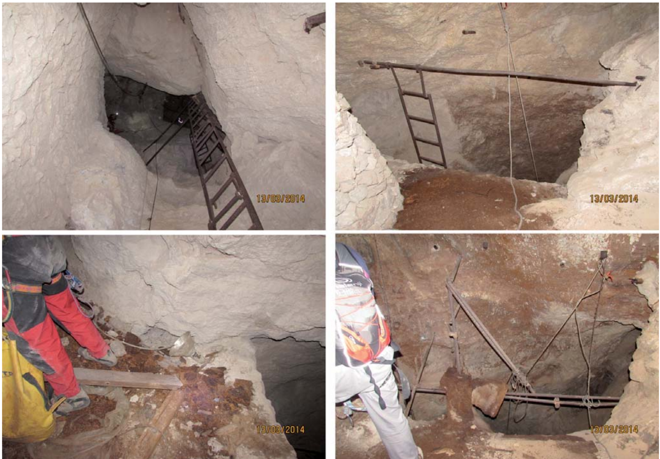
Figura 2. Aspecto del interior del pozo artificial. El material de color marrón oscuro que se observa en las fotos es el serrín que formaba los tableros de aglomerado
