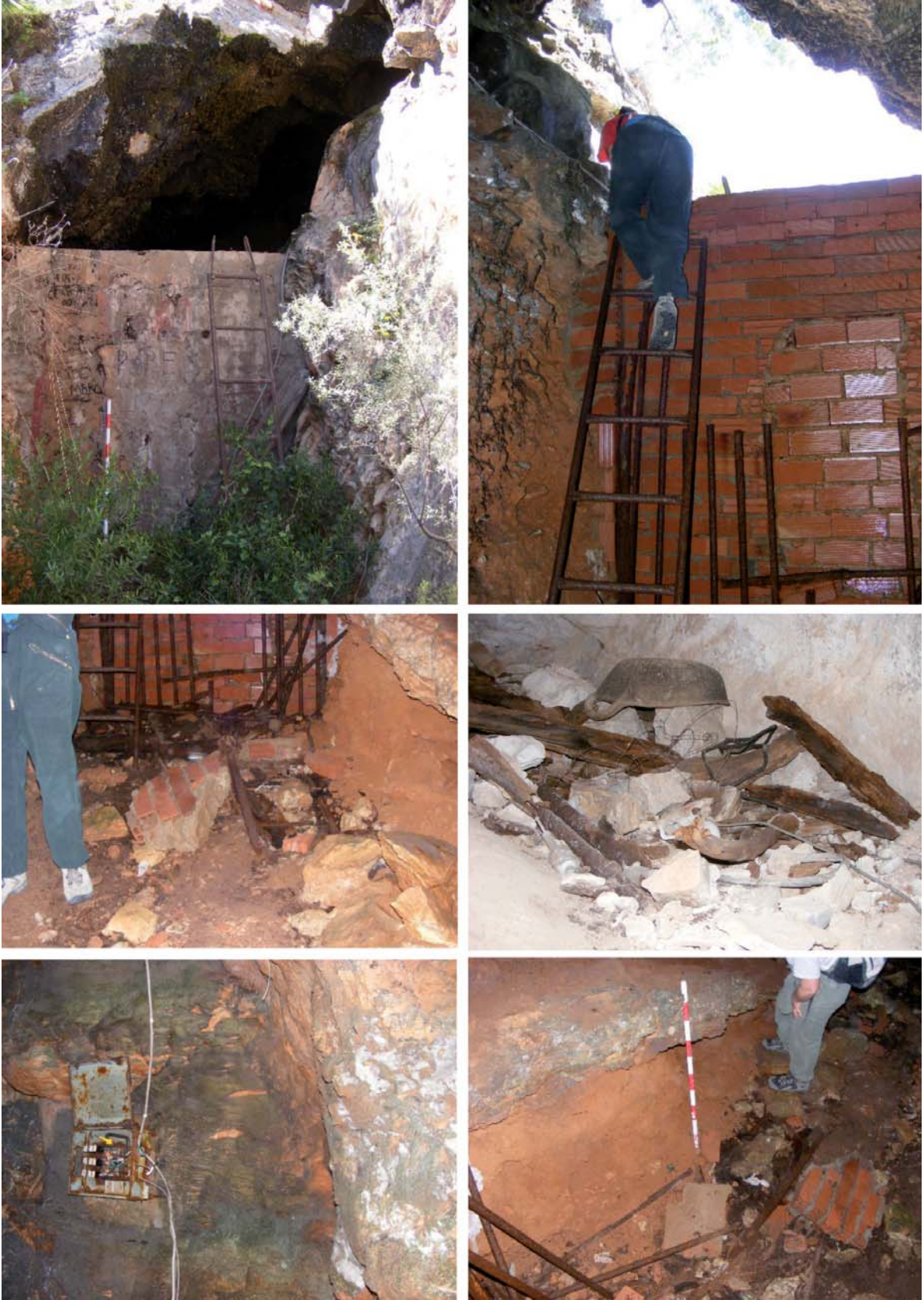
Figura 1. Imágenes de las dos caras del muro que cerraba parcialmente la entrada a la Cueva Pintada (arriba) y del estado de la misma en abril de 2013. En la última imagen se aprecia el relleno sedimentario próximo a la boca
