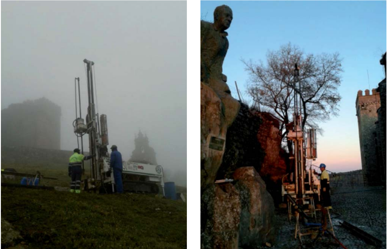
Figura 3. Imágenes del equipo de perforación Rolatec RL 48-M utilizado en las dos perforaciones realizadas en el Cerro del Castillo (izquierda, sondeo 1 y derecha, sondeo2) (Fotografías: W. Martín)
