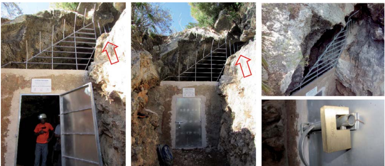
Figura 4. Cerramiento actual de Cueva Pintada. Las imágenes de la derecha muestran un detalle de la abertura superior, que permite el paso libre de los murciélagos más sensibles a las rejas, y el candado de seguridad que cierra la puerta
