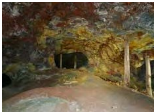
Figura 11. Labores subterráneas con sostenimiento.
