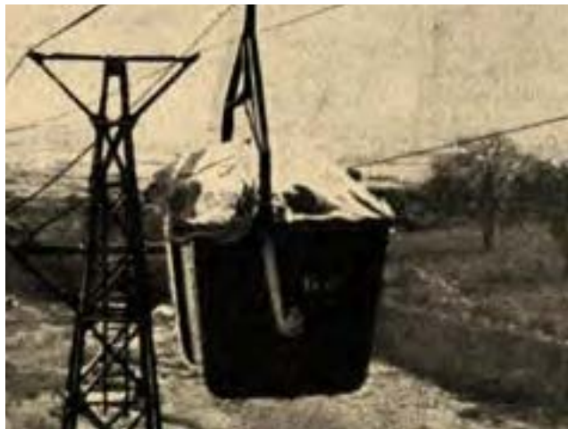
Figura 5. Cable aéreo de La Lima (cortesía de Chaves).
