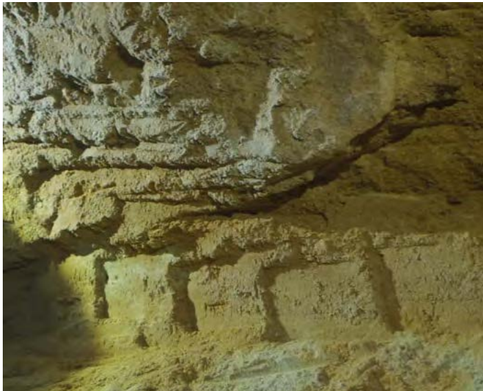
Figura 8. Marcas de herramienta de arranque en un hastial de la mina de agua del Puerto de Brenes (Orche, 2015).
