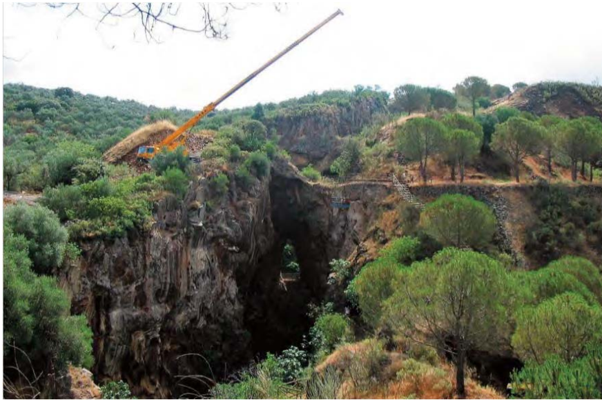
Figura 3. Acondicionamiento de la mina. Trabajos de bulonado con grúa en la zona del colapso.
