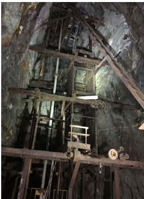
Figura 7. Castillete en el interior de la Mina Monchi. Minas de Burguillo del Cerro.
