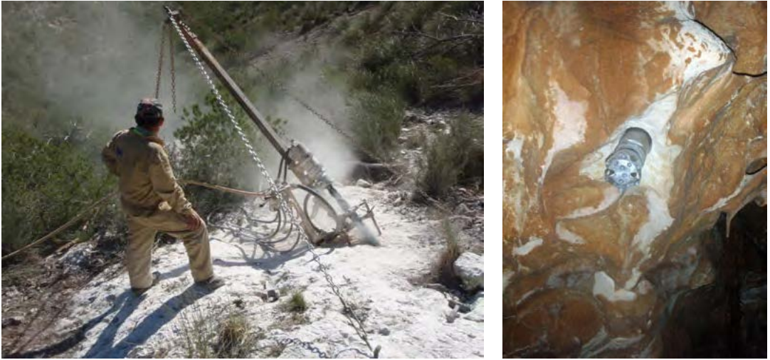
Figura 10. Realización del sondeo a destroza e imagen del martillo en la sala de Los Garbanzos, certificando la exactitud de los trabajos realizados.
