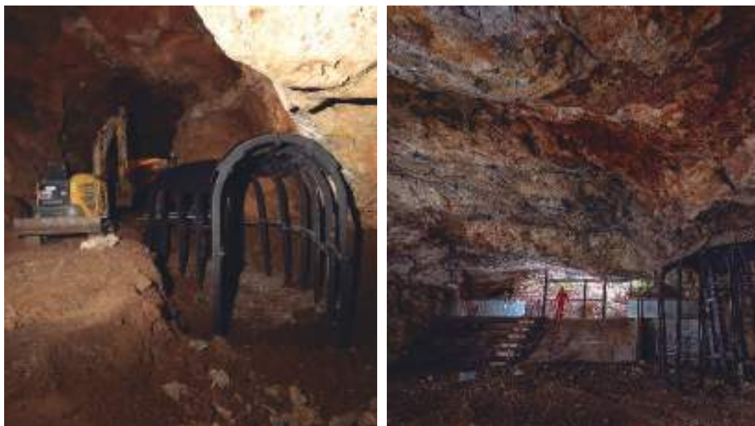
Figura 8. Trabajos de acondicionamiento y seguridad en la mina Victoria (izq). Actuaciones de seguridad y acondicionamiento de galerías y techos en Victoria II (der).
