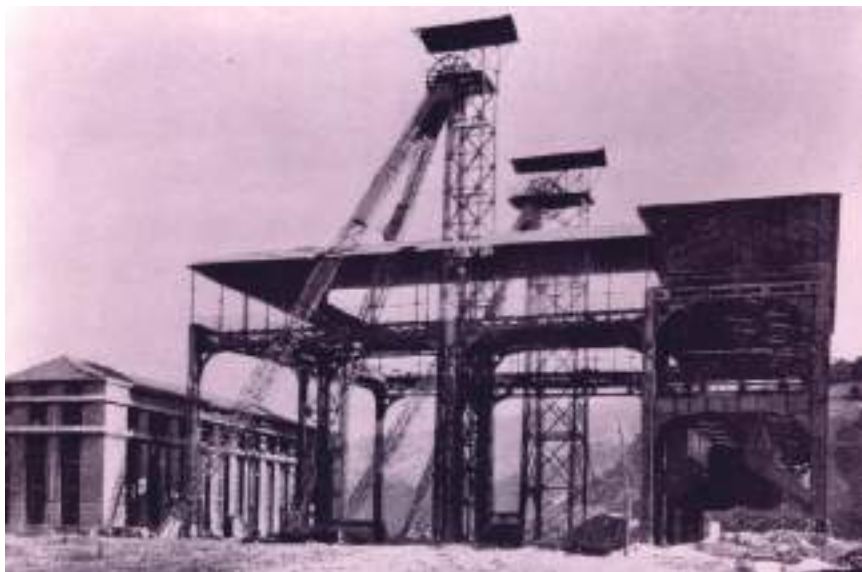
Figura 1. Vista de los castilletes, réter y edificio de oficinas del pozo Sotón a primeros del siglo XX. Fuente: Archivo Histórico de HUNOSA – Pozo Fondón.
