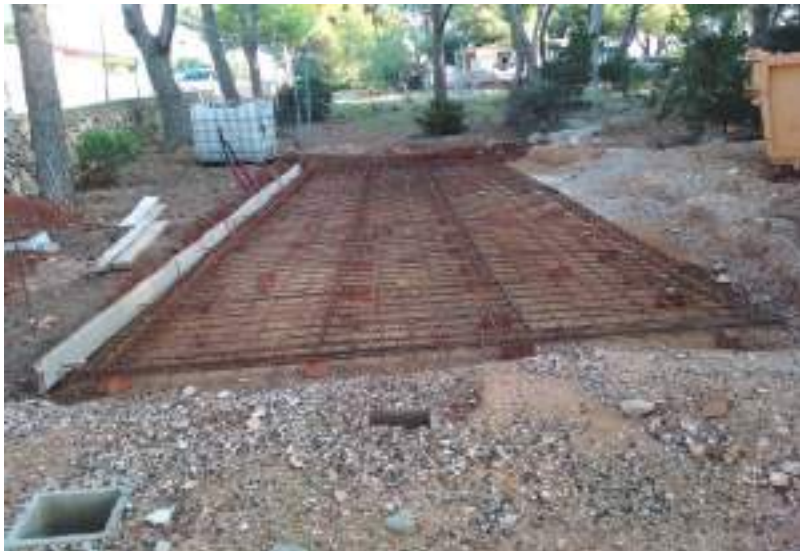
Figura 3. Encofrado de la zona exterior de acceso a la cueva.
