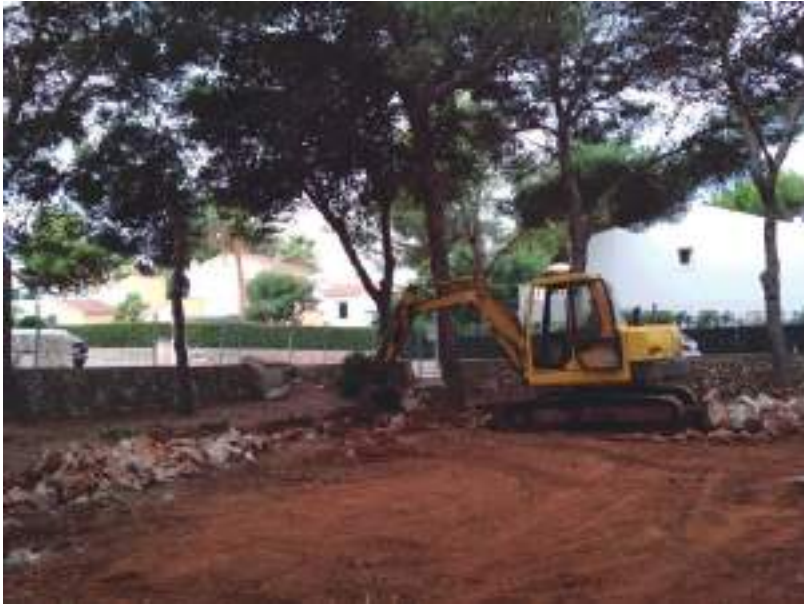
Figura 2. Inicio de las obras de habilitación de la cueva en el exterior.
