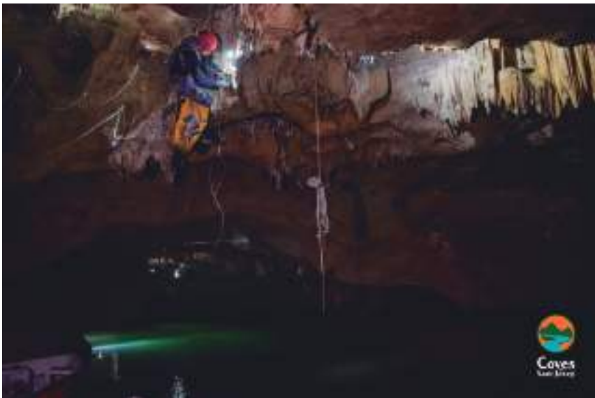
Figura 1. Instalación nueva iluminación y sistema de fibra óptica Coves de Sant Josep.
