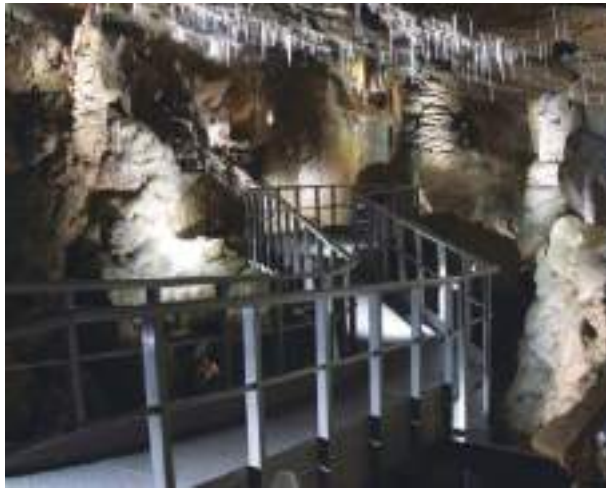
Figure 3. Cheminement en FRP (Fibre Plastique Renforcée) grotte de Herbstlabyrinth Allemagne)
