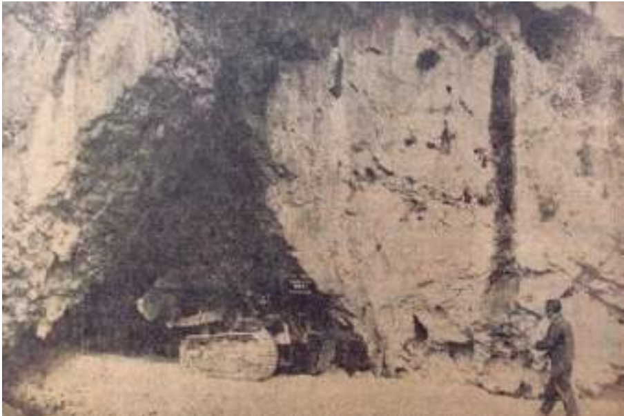
Figura 9. Obras de apertura del túnel artificial de acceso a Tito Bustillo desde Ribadesella. La Nueva España.
